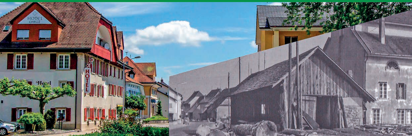
Die alte Sägerei, später das Personalhaus für Von-Roll-Mitarbeitende, am heutigen Pfluger-Platz.
