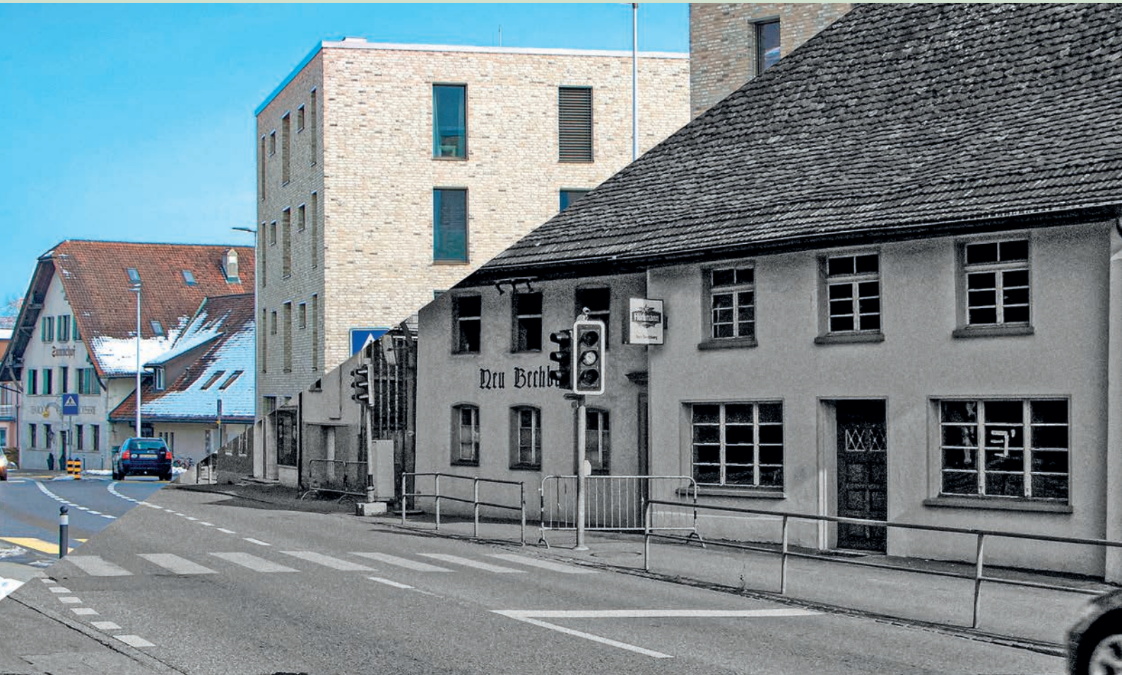
Das damalige Restaurant Neu Bechburg und die heutige Überbauung Roggenpark.
