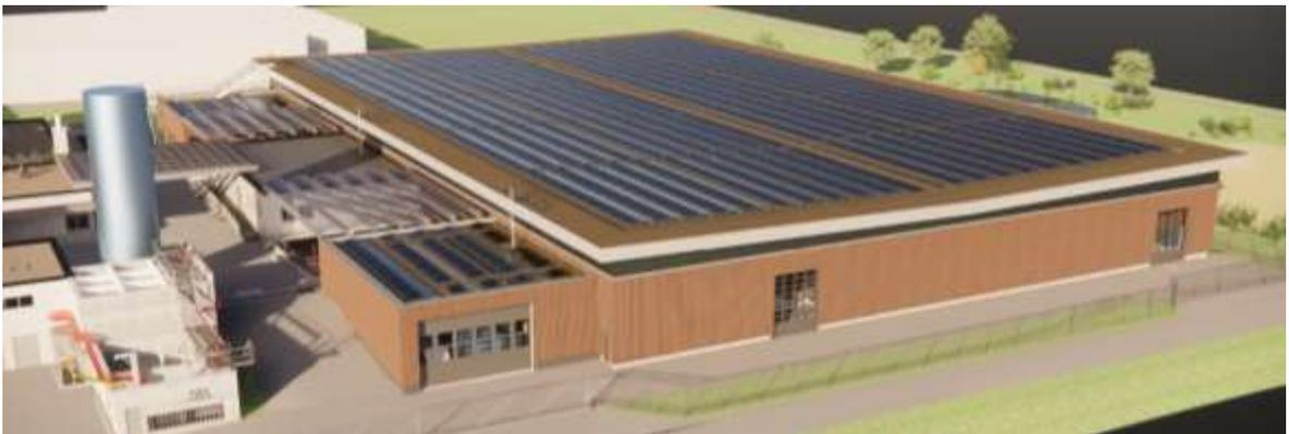
**Abbildung 15: Photovoltaik-Module auf Wetterschutzhalle und Nebengebäude**
